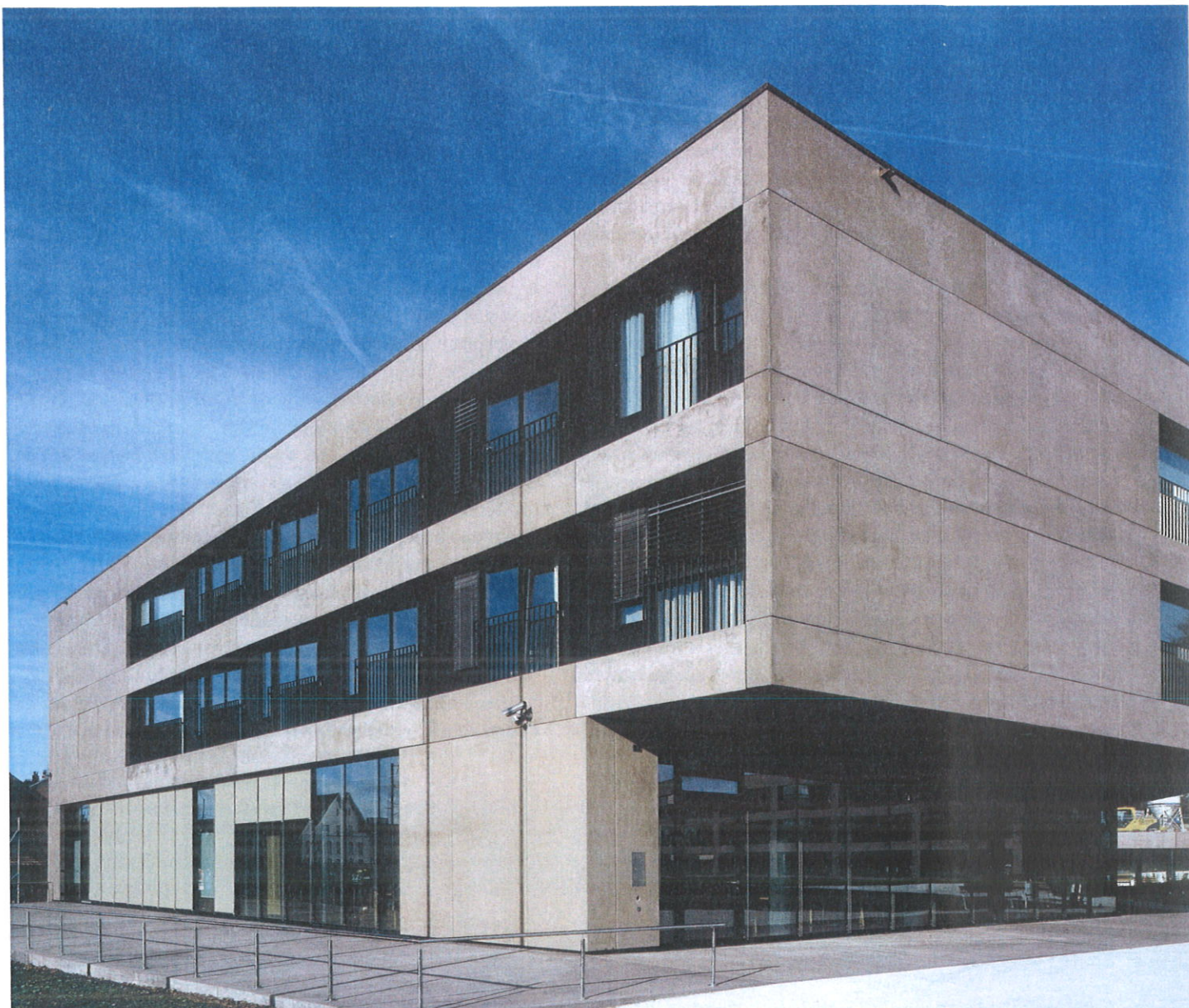
Alterszentrum Sophie Guyer, Pfäffikon ZH: «Der Markt verlangt nach Alterswohnungen und Wohnstrukturen, die dank Spitex oder dank Nachbarschaftshilfe ein weitgehend selbstständiges Leben ermöglichen.»
